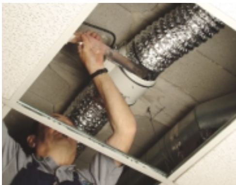
7 Selar as condutas com fita adesiva.
