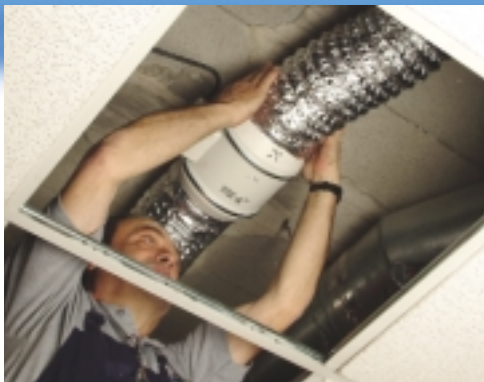
6 Acoplar as condutas.
